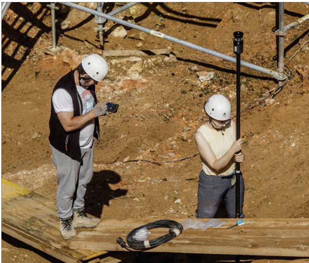
Cada yacimiento cuenta con una estación total, aquí trabajan en Cueva Fantasma haciendo topografía digital y clásica. SANTI OTERO
