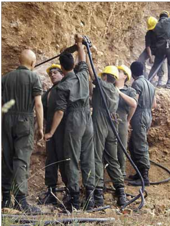
Un grupo de militares del Regimiento de Ingenieros 5 de Castrillo del Val barrenando la zona de sedimentos estériles de Galería para su explosión en la campaña del año 1986. MARIANO BAUTISTA
