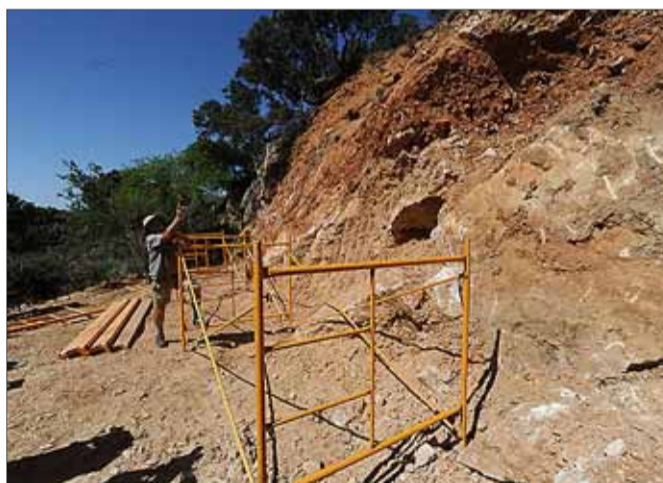
En los primeros días de trabajo se instalaron los andamios. ILM
